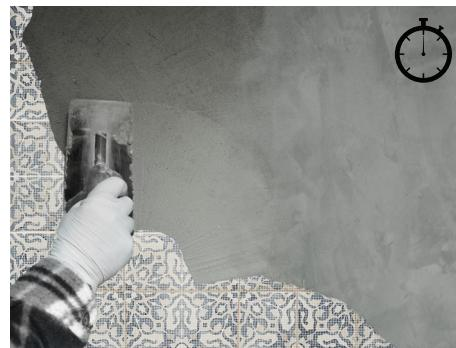
2. Colocação de rede sobre o substrato e aplicação da primeira demão do KONCRETO® R.
